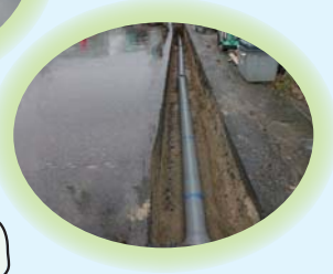
▲ 耐震管への布設替え (鋼鉄製耐震管)
