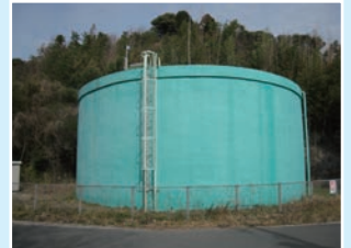
かんのんじ 観音寺配水池：1100 m 3
